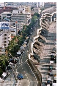
地震で倒れた高速道路
